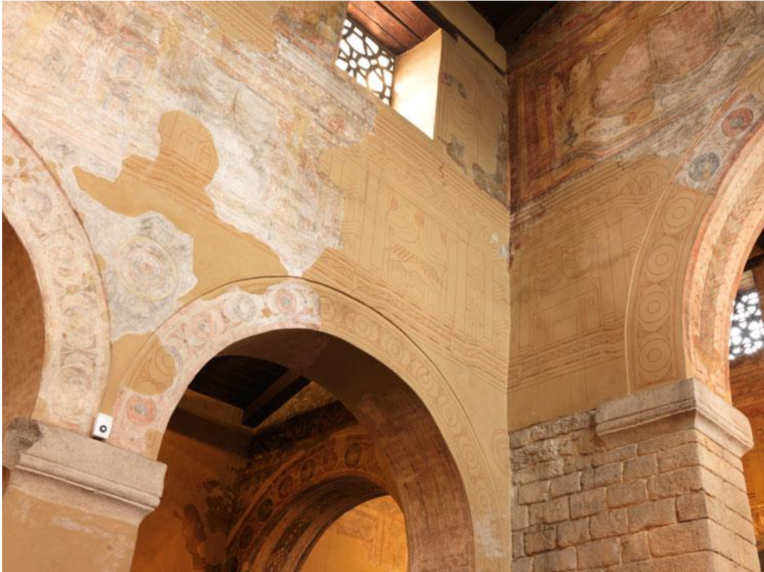
Figura 1: Estudio de condiciones ambientales sobre las pinturas murales en la Iglesia de San Julián de Prados (Oviedo). Fuente: Web IPCE.
